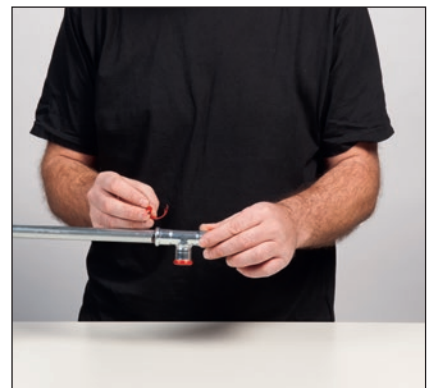
Abb. 19: Entfernen des Pressindikators
