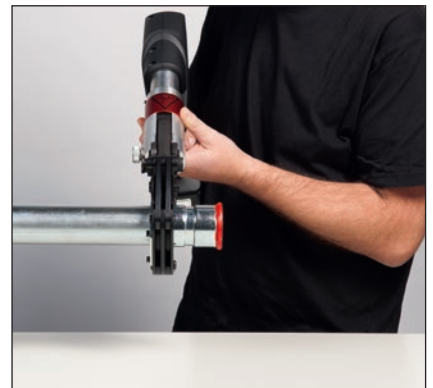
Abb. 19: Entfernen des Pressindikators
